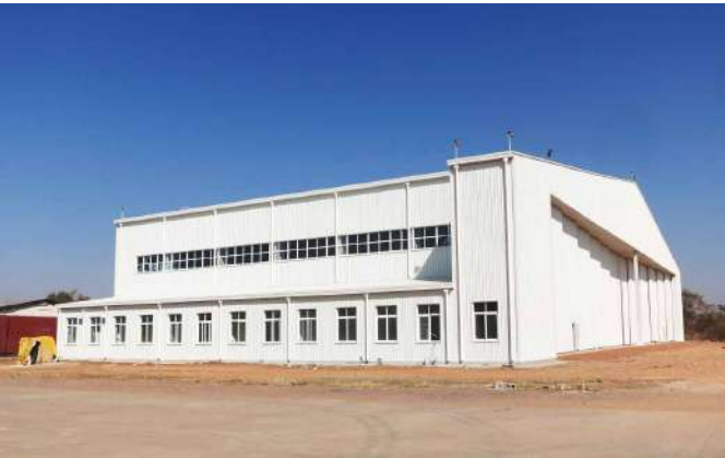
赞比亚空军机库 The Zambia Air Force Hangar 建筑面积: 3500m 2 Construction area: 3,500m 2 结构形式: 门式刚架 Structure type: Portal frame
